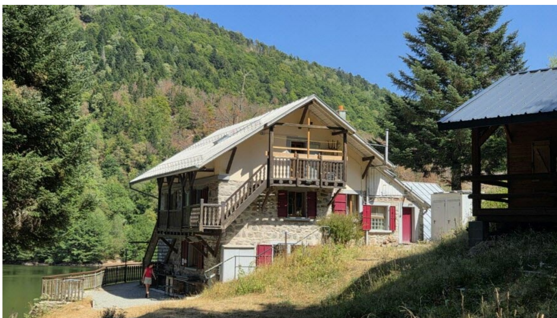
L'auberge fait régulièrement l'objet de travaux d'entretien assurés par les bénévoles du CVM. Le prochain concernera la rambarde d'escalier qui permet d'accéder aux chambres.
